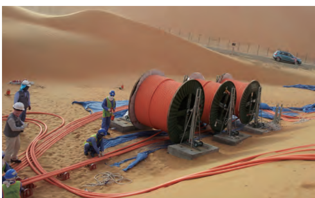
HV Cable Pulling
